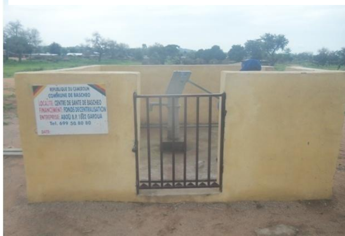
Photo 2: Une installation hydraulique à Baschéo
